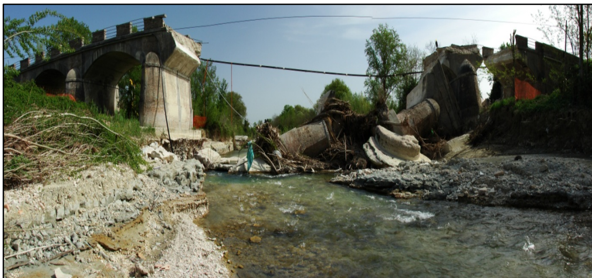
Veduta da monte del ponte crollato.
